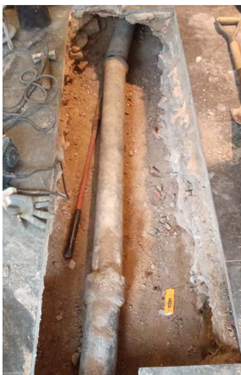
Fotografia 2. Serveis que van deixar al descobert els treballs.
