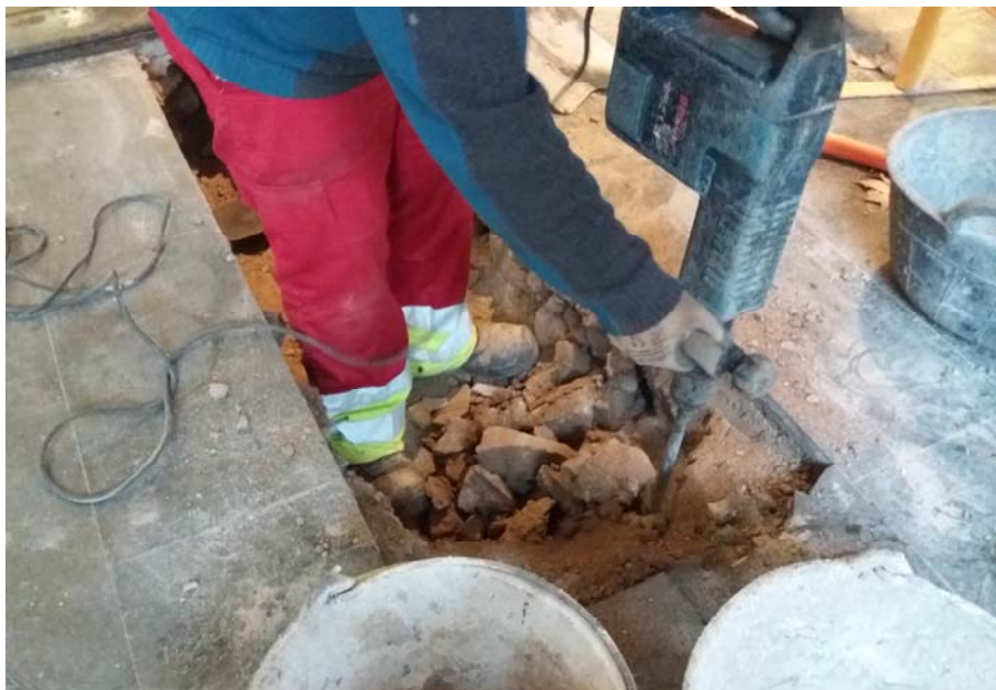
Fotografia 3. Tasques d'obertura de la rasa.
