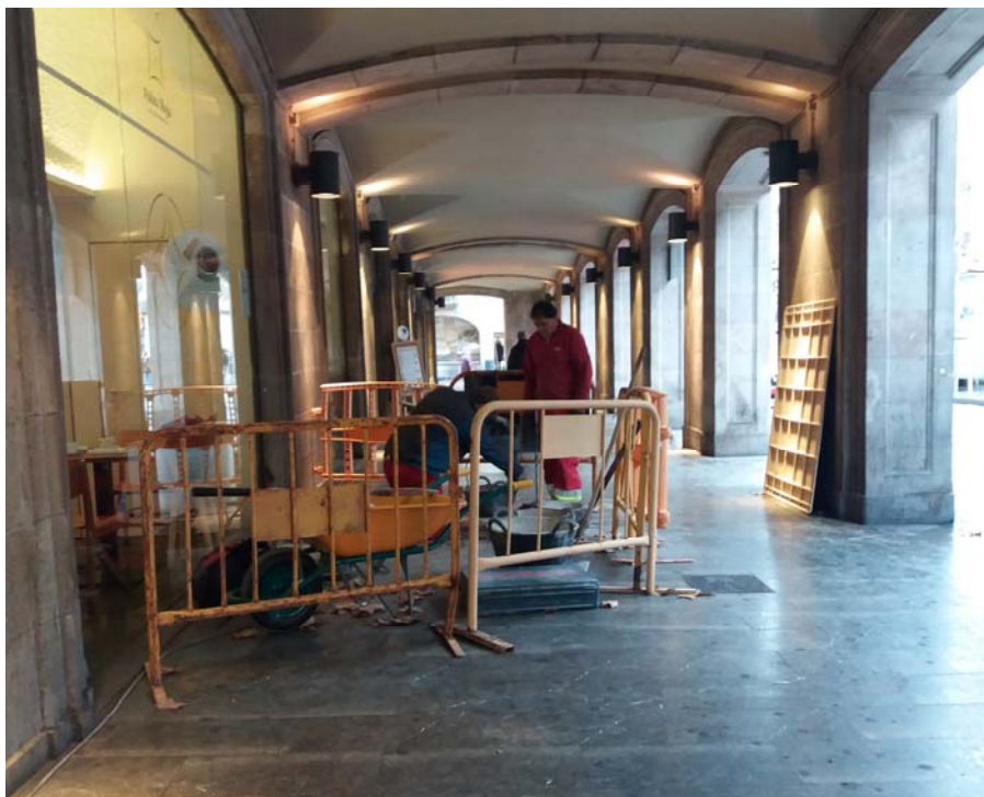
Fotografia 1. Detall de la Rambla abans de començar els treballs.
