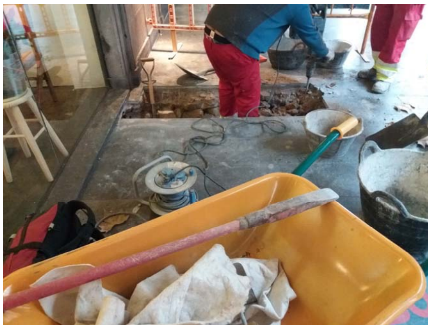
Fotografia 4. Detall dels treballs realitzats.
