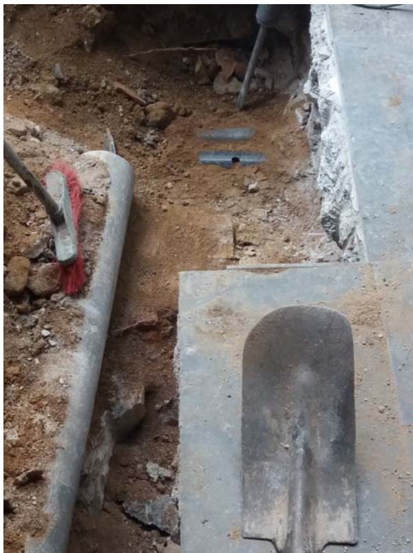
Fotografia 5. Detall d'un tram de la rasa després del buidatge de terres.
