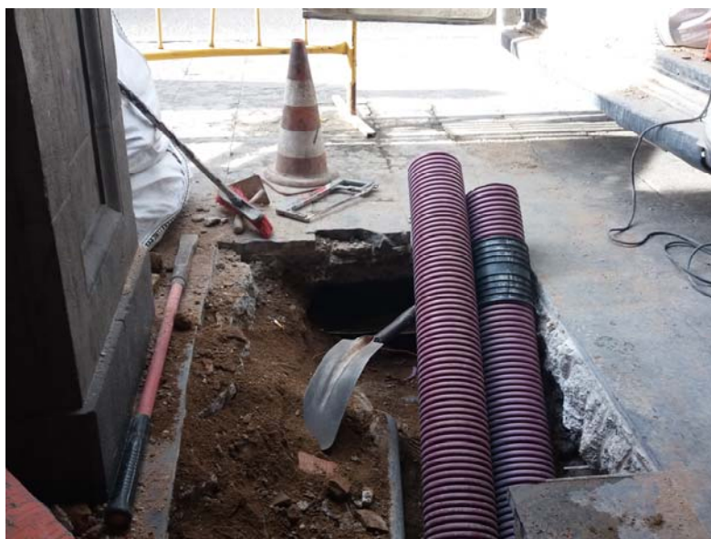
Fotografia 6. Altra tram de la rasa un cop fet el buidatge on es pot veure els serveis que es trobaven en aquesta zona.
